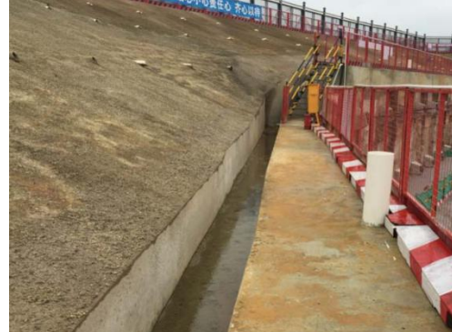
图 5.5.3.2-4 灰砂砖排水沟
