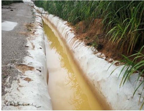
图 5.5.3.2-1 土质排水沟（表面铺土工布）
